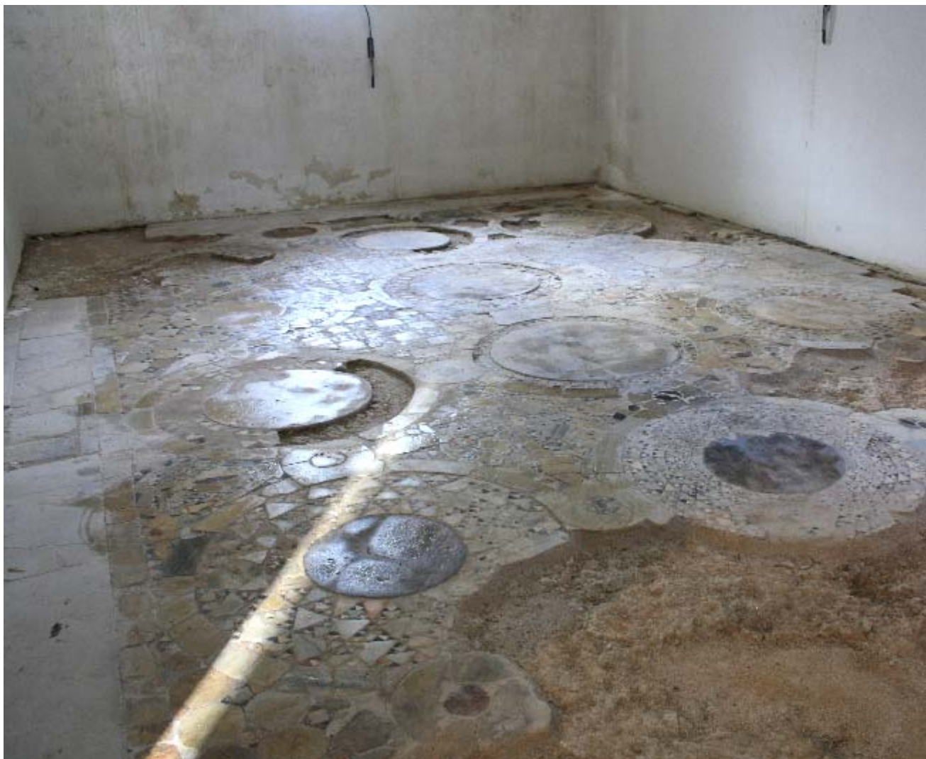
Fig 73 Veduta generale dalla soglia d'ingresso del pavimento del locale L2
